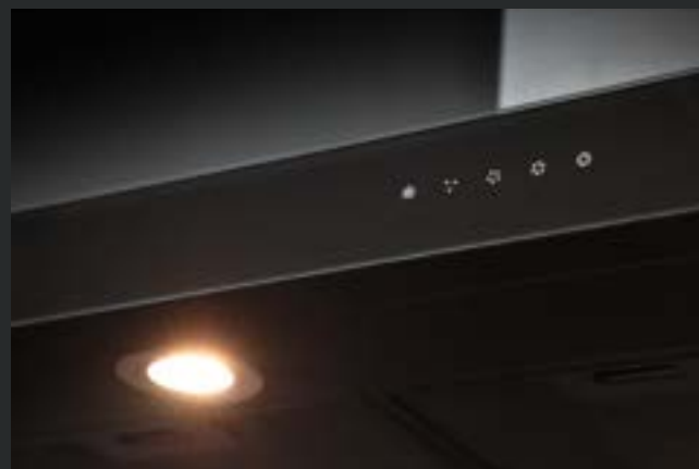
LED照明系統
